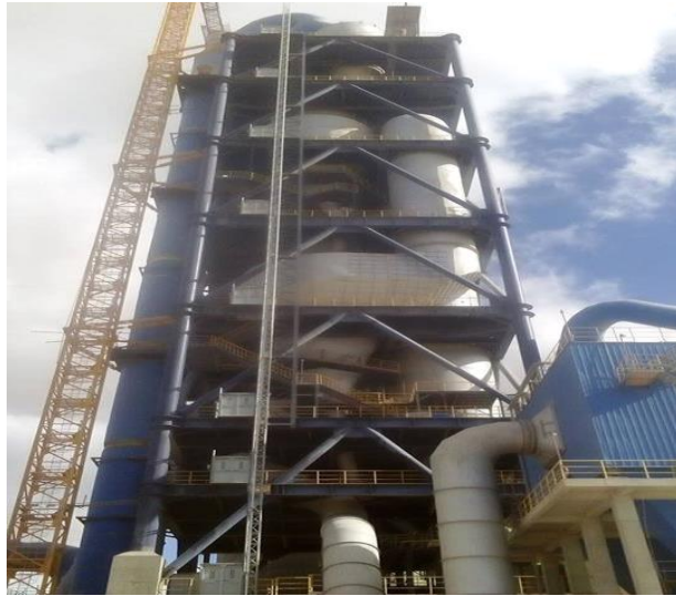
Figure I.8 : Préchauffeur ou cyclones
