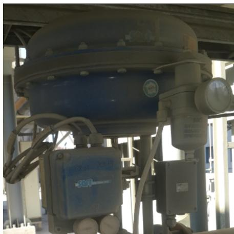
FIGURE 2.15 – Servomoteur pour une vanne régulatrice [1].
