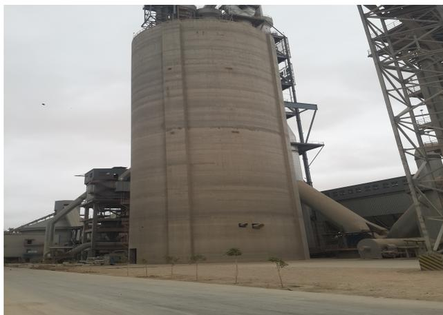
FIGURE 1.8 – Silo de stockage et d'homogénéisation [1].
