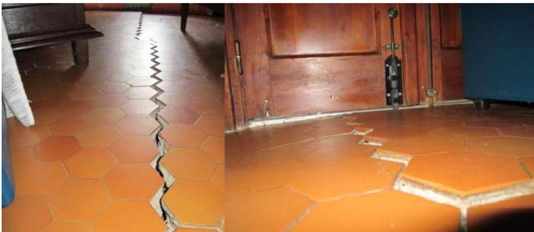
*Figure I. 15. Fissures apparaissent dans la maison en raison du sol argileux (Bodin et al., 2015, SEC 2015).*
