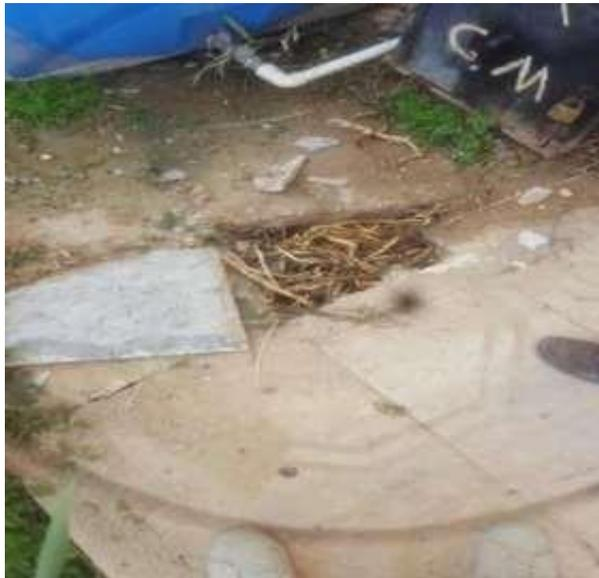
*Figure I. 31. Dégradation d'une dalle béton par des racines d'arbuste ayant colonisé une fissure (CEIL de l'université de Biskra, Chetma, 2020).*
