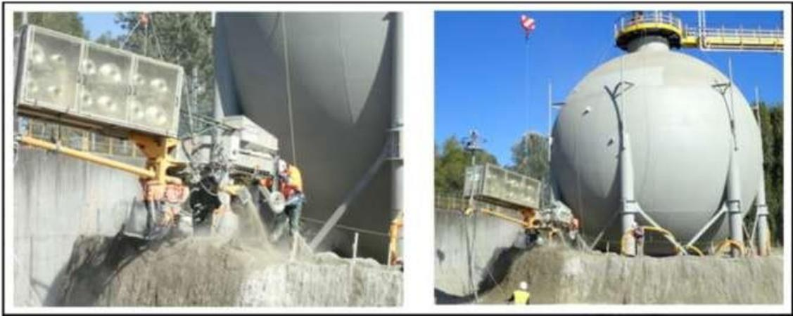
*Figure I. 41. Protection d'un réservoir de gaz par un massif de sable renforcé par des fibres continues – Procédé Texsol [Source : © Photothèque J.P. Gourc]*
