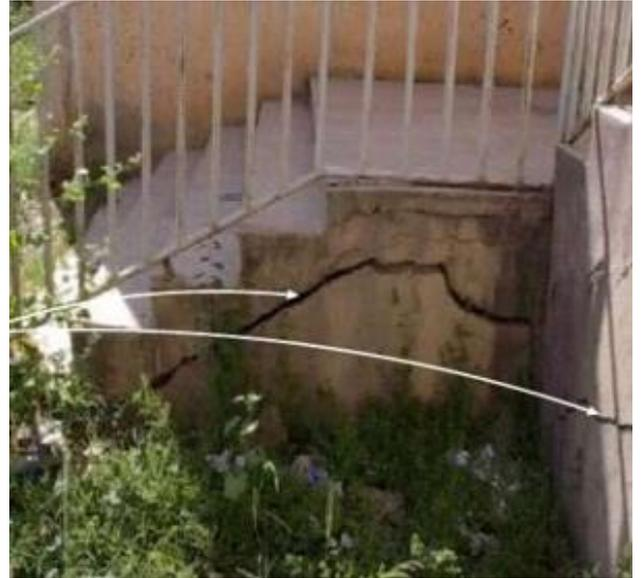
*Figure I. 32. Fissurations excessive sur les parois d'une cage d'escaliers (Bourabah, 2006).*
