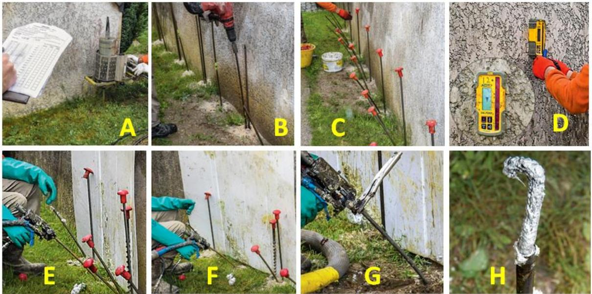
*Figure I. 35. Mode opératoire de la technique de l'injection de la résine*
