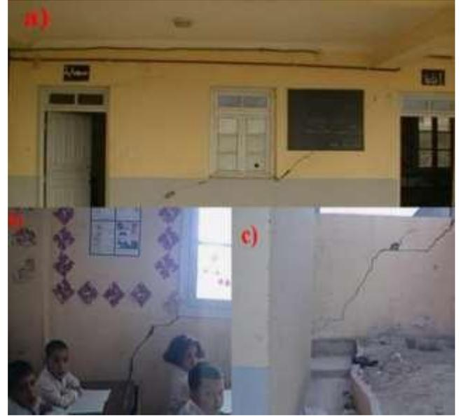
*Figure I. 30. Fissuration sur les murs site de Sidi-Aissa/M'sila (Salem, 2018).*
