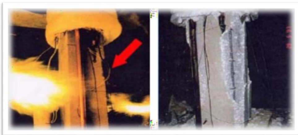
Figure II.18 :Eclatement d'un poteau durant l'essai au feu. [Saadi Imene,2017].
