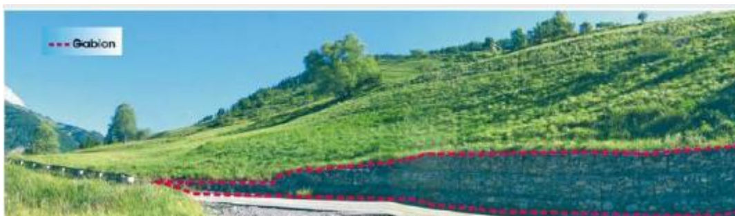
Figure-I-17 Réalisation d'un mur en gabion(12)
