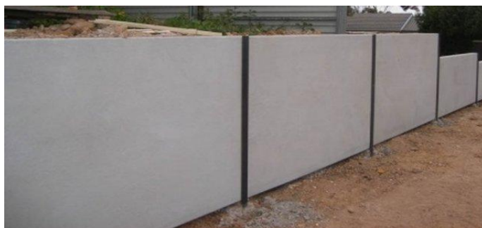
Figure-I-15 Paroi en béton (15)
