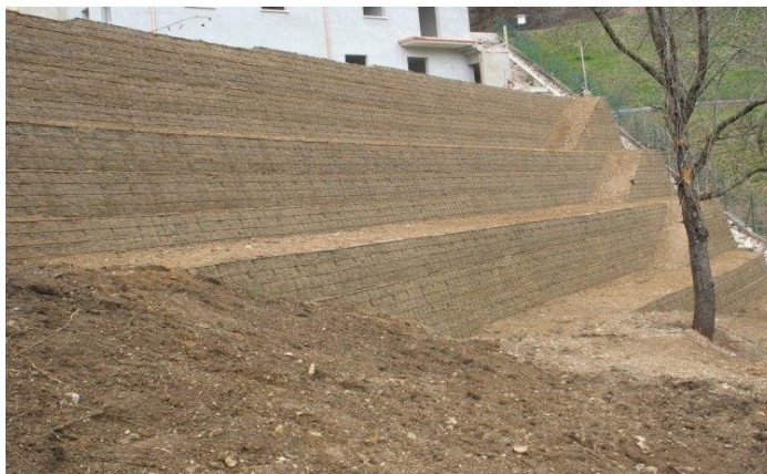
Figure-I-13 Murs en sol renforcé (15)
