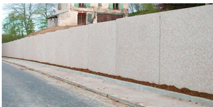
Figure-I-12 Murs en béton armé(15)
