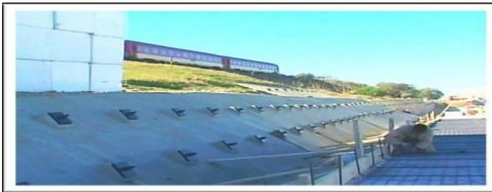
Figure-I-3 Stabilité d'un glissement avec tirant d'ancrage (2)
