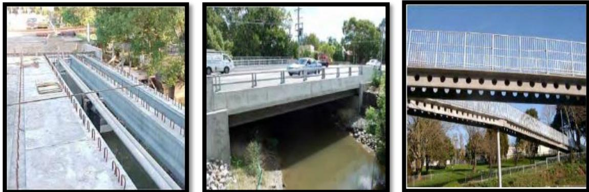
Figure I.8 : différent éléments structurels en BPR. [Malik, 2007]
