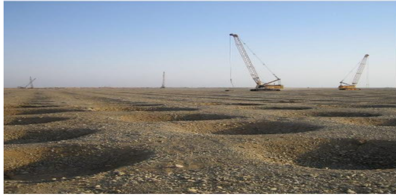
Figure I.18 Exemples de chantiers de compactage dynamique [22].
