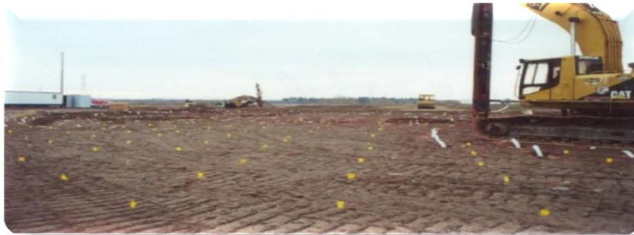
Figure I.11 Chantier de réalisation des drains verticaux [15].
