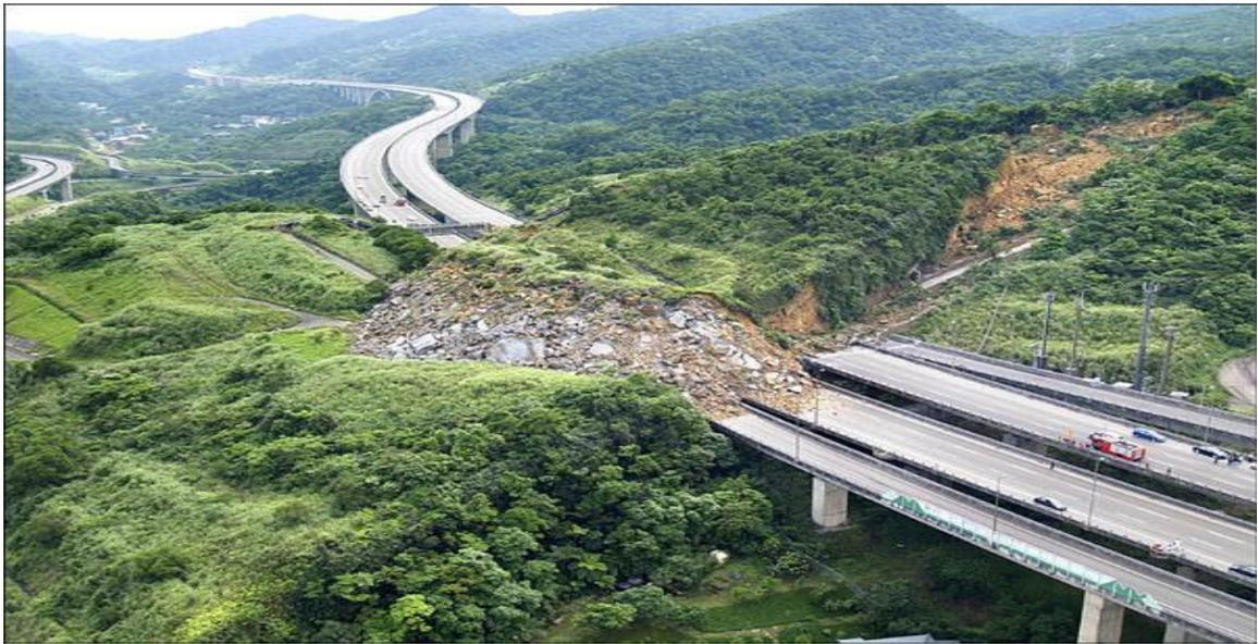
**Figure I.18 :** Glissement de terrain sur l'autoroute n°3 à Taïwan [17].
