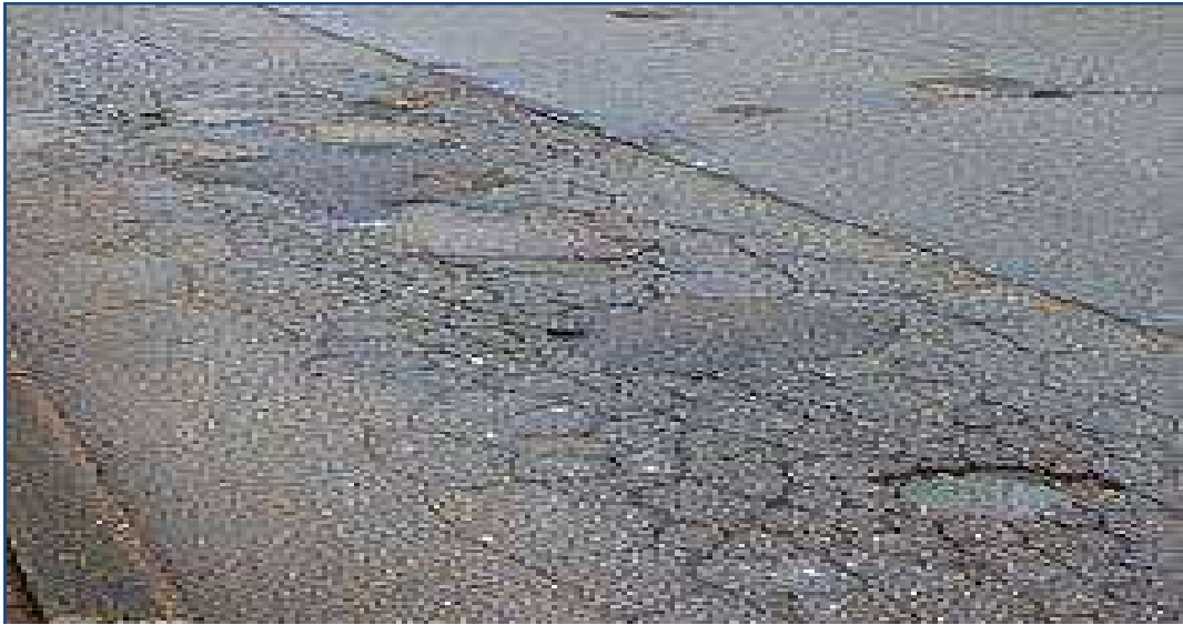
Figure I.5: La chaussée existante.
