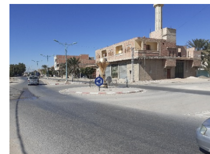
PHOTO I-18 : un carrefour giratoire au centre de la ville
