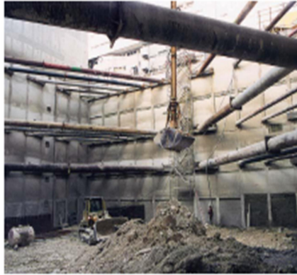
Figure I.12. Renforcement par butons. Figure I.13. Renforcement par tirants.
