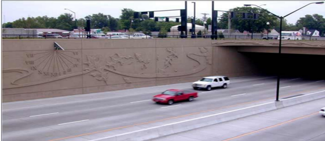
Figure 1.1 : mur de soutènement
