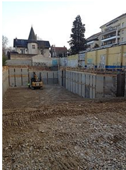
Figure I.11. Paroi berlinoise entourant le volume en cours de terrassement d'un sous-sol.
