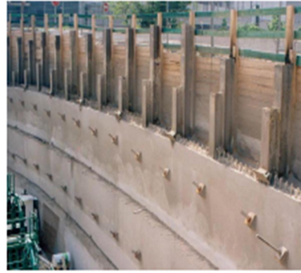
Figure I.12. Renforcement par butons. Figure I.13. Renforcement par tirants.
