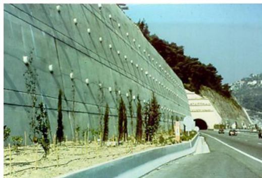
Figure I.15. Exemple de mur cloué.
