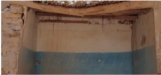
صورة رقم -42-: التلبيس الداخلي
