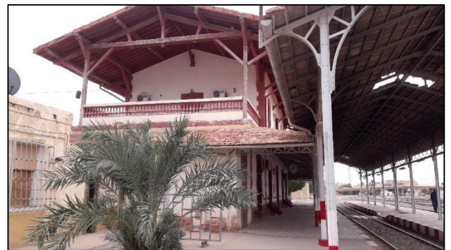
Figure 25 : vue la gare de Biskra. Source : l'auteur 2020.
