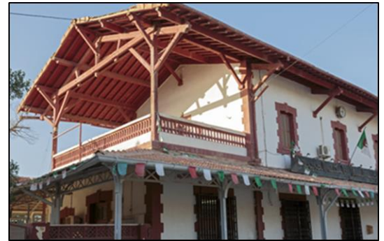
Figure 44 : la charpente en bois Source : auteur2020.
