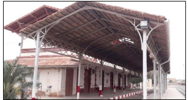
figure36 : le bâtiment voyageur. Source : auteure2020.
