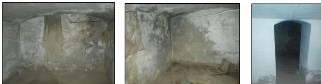
Figures 64, 65, 66 : mur porteurs sous-sol
