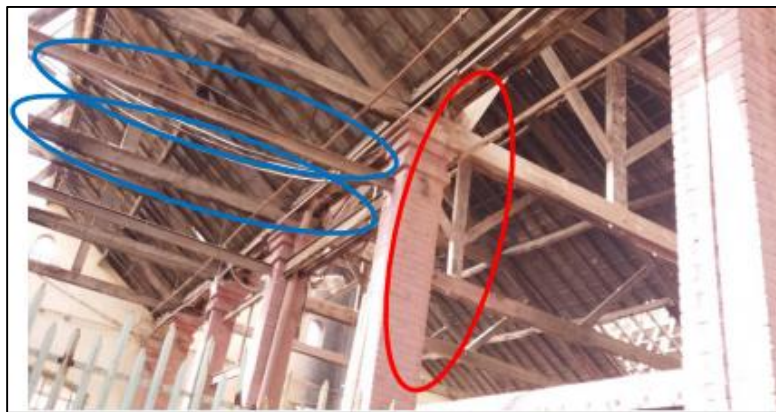
Figure 59 : structure de l'atelier
