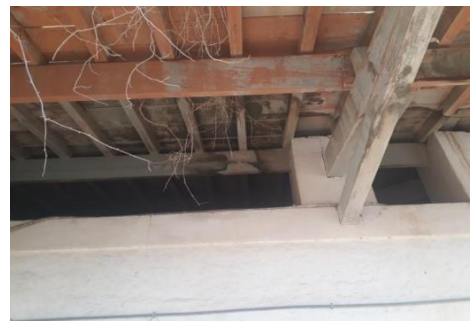
Figure 63 : la charpente en bois
