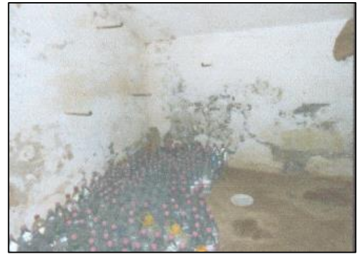
Figure 40 : le sous-sol Source : auteur2020.
