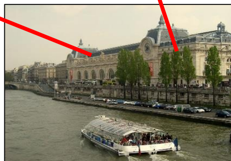
Figure70 : façade sur la seine
