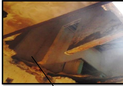
صورة 76: توضح ظهور التسليح وسقوط روافد من الحديد المعدني IPN المصدر: الطالبة 2019.
