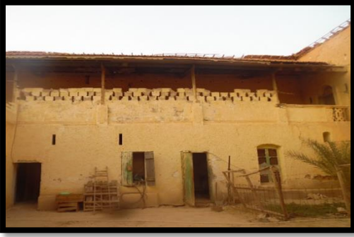
صورة 50: الواجهة الشمالية (الجهة اليمنى). المصدر: الطالبة 2019
