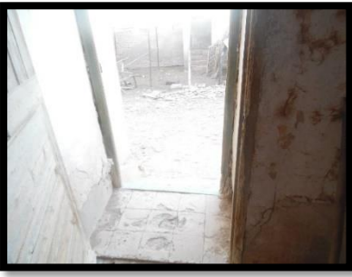
صورة 71: جدران قاعة الاستقبال للمسكن المستقل المزدوج متأثرة بالخاصية الشعرية المصدر: الطالبة 2019 .
