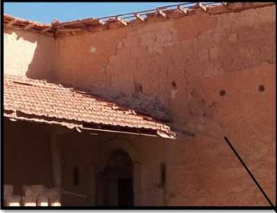
صورة 77: توضح حالة القرميد من السقف. المصدر: الطالبة 2019.
