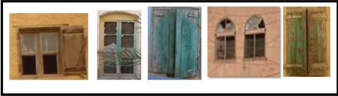
صورة65: صور مختلفة لنوافذ المبنى المتواجدة حاليا (برج لورير).
