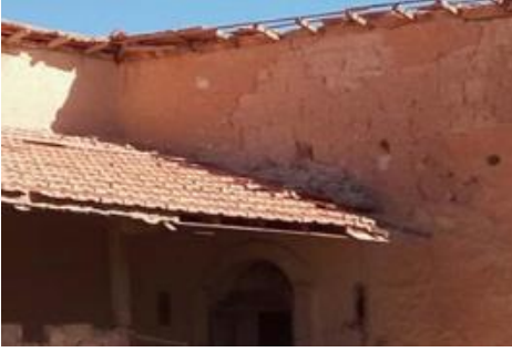
صورة 30: القرميد المسطح Tuile Plat المصدر: الطالبة 2019
