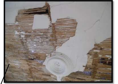
صورة 75: توضح تنافر طبقة الجبس من السقف المصدر: الطالبة 2019.
