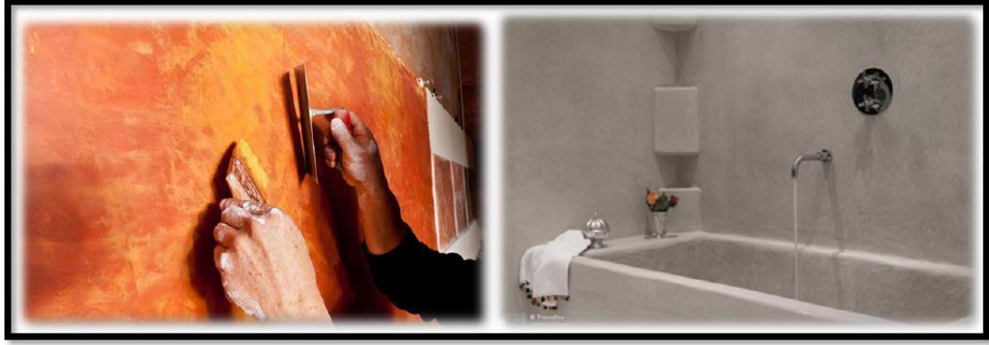
الصورة 97: مناظر لمجالات عالية الرطوبة ذات التلبيس بجبس مغربي المضاد للرطوبة العالية، ومنها الحمام.
