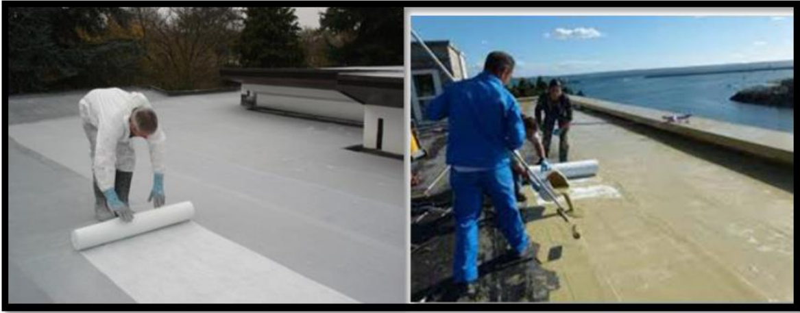
الصورة 99: مناظر عمل طبقة الكتامة للسقف، بواسطة ألياف تغطي السطح كله ومواد عازلة.
