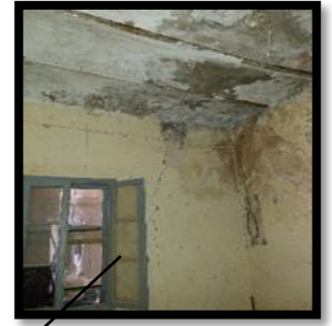
صورة72: ظاهرة التكثف في غرفة الاستقبال الغير معرضة لأشعة الشمس المصدر: الطالبة 2019.
