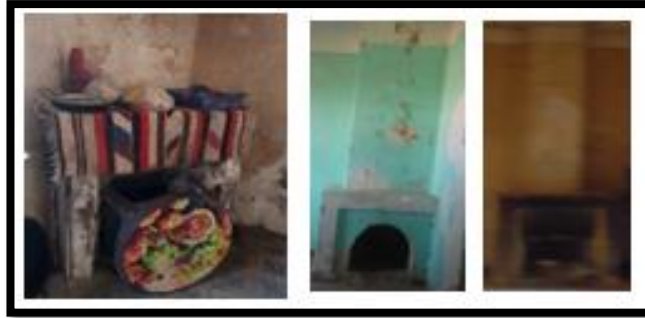
صورة 68: نماذج المداخن الموجودة في المبنى المصدر: الطالبة 2019
