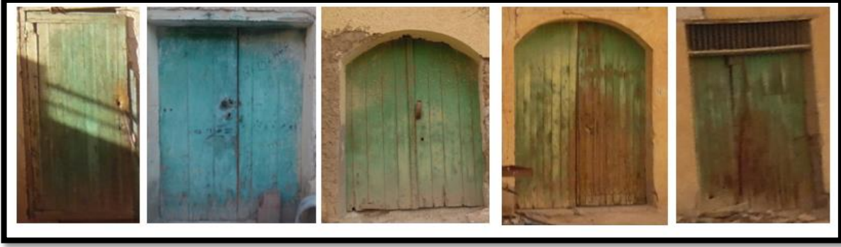
صورة64: صور مختلفة لأبواب المبنى المتواجدة حاليا (برج لورير)
