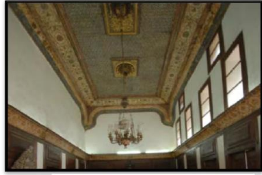
صورة 86: سقف غرفة الاستقبال.
