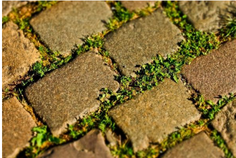
Figure I.34 : revêtement routier écologique
