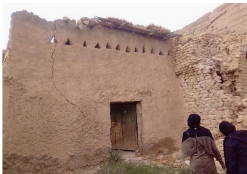
Figure I.36 : les petites ouvertures et le revêtement au niveau de la façade à Mechounech
