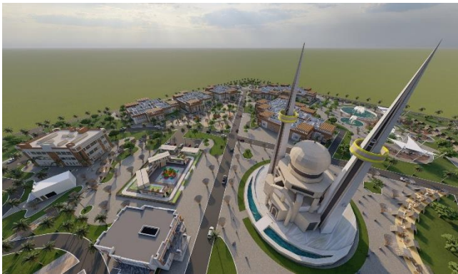
Figure III.132 : Vue générale d'après la mosquée (Source : Auteur, 2020)
