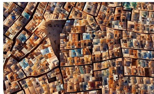
Figure I.27 : vue d’en ciel du ksar Beni Isguen montre le tissu compact de la région.
