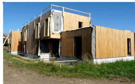
Figure II.61 : L’ossature en bois
