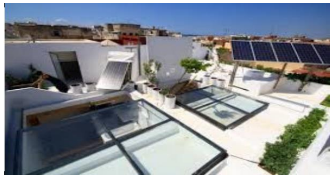
Figure II.65 : le double vitrage des verrières
