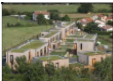
Figure II.60 : Les toitures végétalisés
