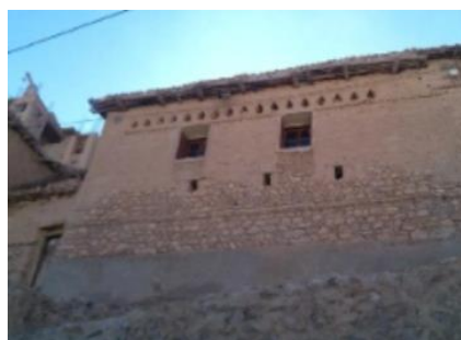
Figure II.83 : les petits trous d'aérations (Source : Document sur Menaà, 2019)
