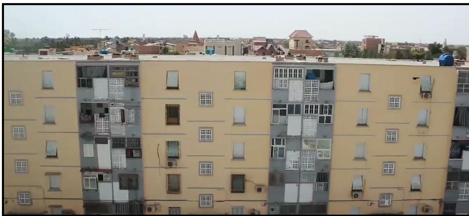
Figure II.72 : La façade Nord : Source auteur 2020
