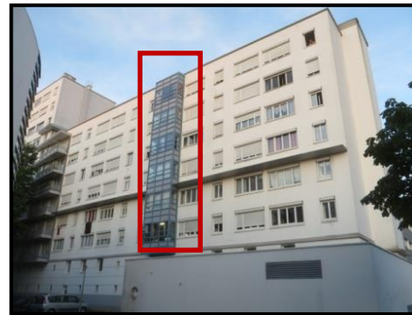
Figure II.27: D1 détail de la façade d'un immeuble. Source : patrimoine.orient/Archi_contemporaine.pdf
