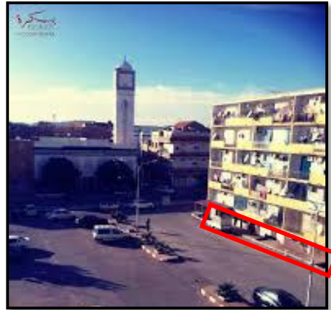
Figure II.69: Vue sur la façade sud montre le sous-sol accessible
