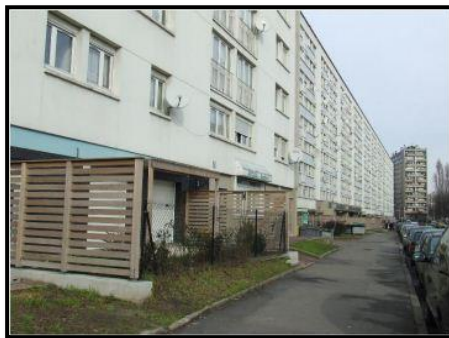
Figure II.35: vue de l'espace extérieur du quartier .Source :(requalification urbain.pdf) 2019)
