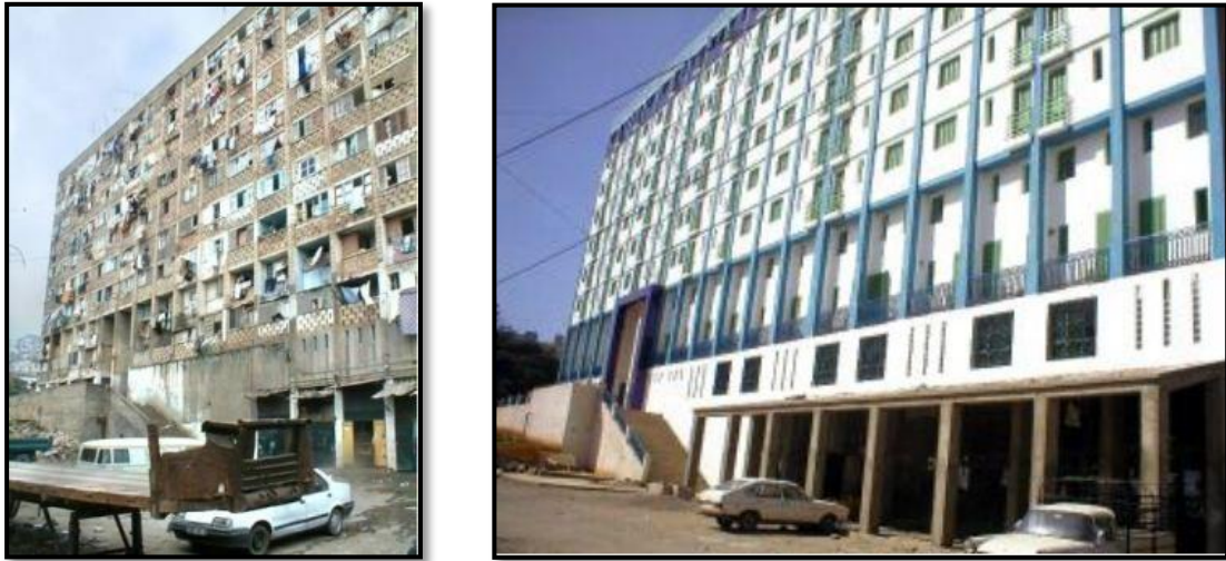
Figure II.41: la façade avant et après l'intervention. Source (Rif, 2016)
