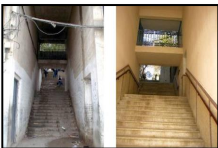
Figure II.42 : une cage d'escalier avant et après l'intervention. Source (Rif, 2016)
