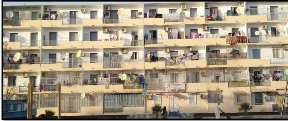
Figure II.73 : La façade Sud : Source : auteur 2020
