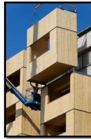
Figure II.32: Vues de l'installation des loggias en bois sur les façades. Source (file : requalification%20urbain.pdf) 2019
