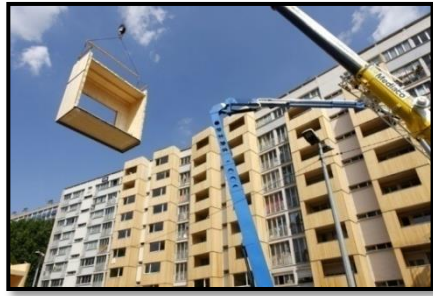
Figure II.32: Vues de l'installation des loggias en bois sur les façades. Source (file : requalification%20urbain.pdf) 2019
