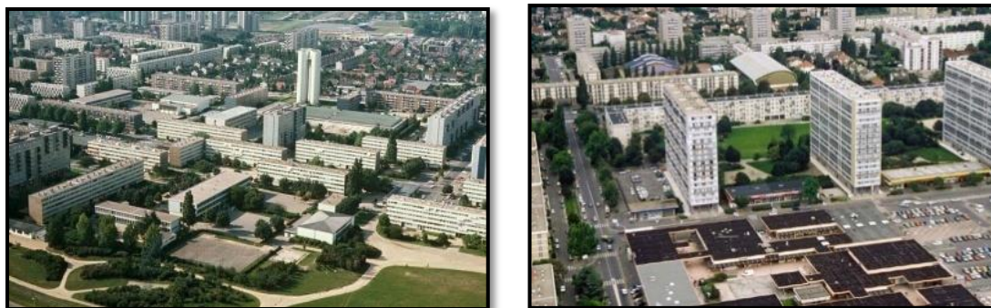
Figure I.1 : Vues aérienne des grands ensembles de Messy-Anthony en France Source : www.agenceaps.com.2020
