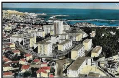
Figure I.5 : vue aérienne Diar el saada Alger. Source: archiwebture.citedelarchitecture.fr.2020
