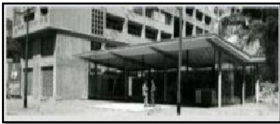
Figure II.48: vue d'entrée d'un immeuble. Source (Stambouli, 2014)
