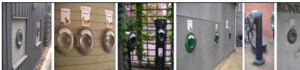
Fig.II.40 : dispositions des bacs de collecte pneumatique.
