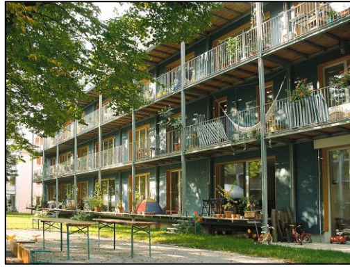
Fig.II.21 : façade sud des maisons passives.
