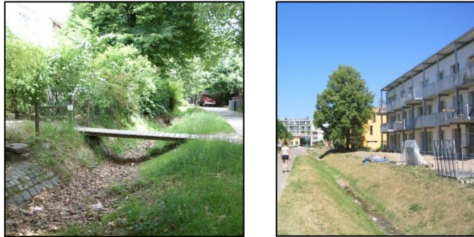
Fig.II.20 : Ruisseaux de rétention.
