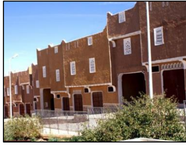
Fig.II.58 : Traitement des façades.
