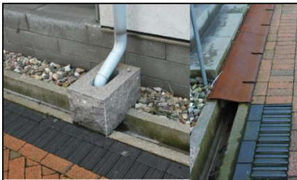
Fig.II.42 : canaux de drainage exposés.
