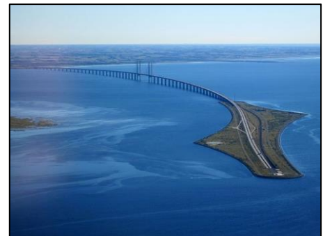
Fig.II.38 : Pont de l' Øresund.
