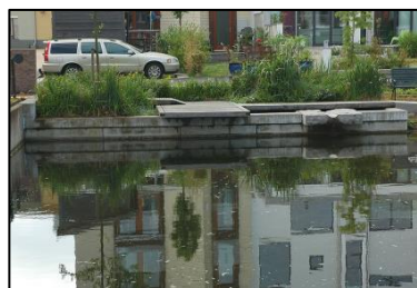
Fig.II.43 : bassins de rétention.
