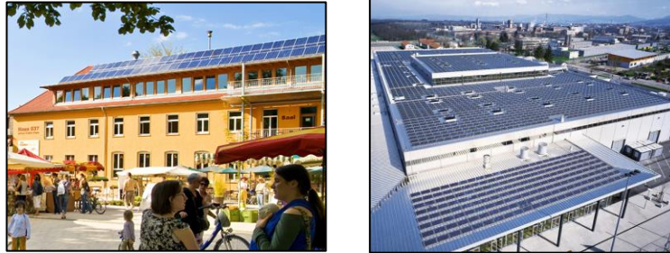
Fig.II.27 : Les photovoltaïques dans les équipements
