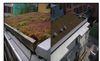
Fig.II.44 : toiture végétalisée.
