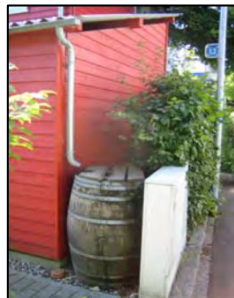
Fig.II.17 : Citernes de récupération.
