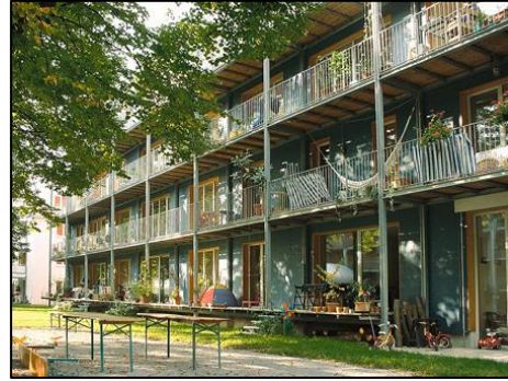
Fig.II.06 : Absence de séparation.
