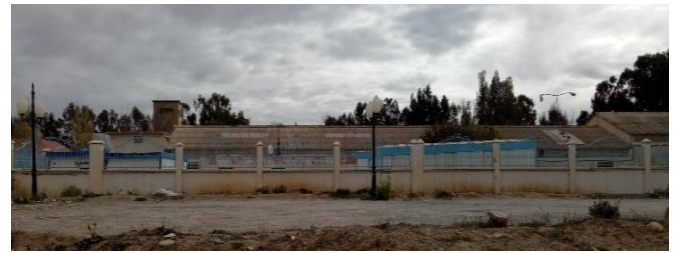
Photo 205 : Photos du périmètre du terrain Source : camera de l'étudiante
