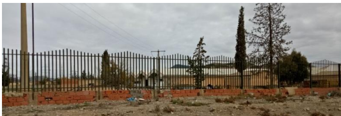
Photo 207 : Photos du périmètre du terrain Source : camera de l'étudiante
