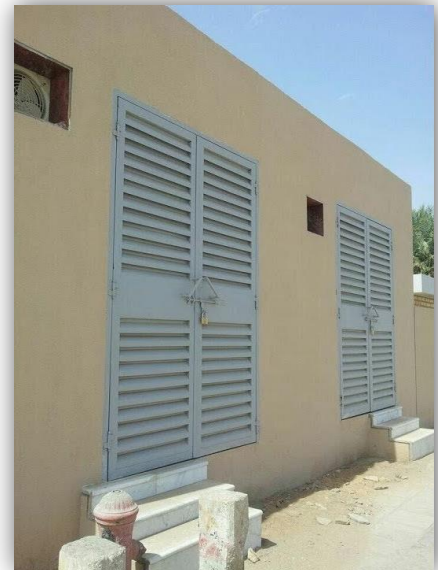
Photo 82: Salle des transformateurs Source : YouTube
