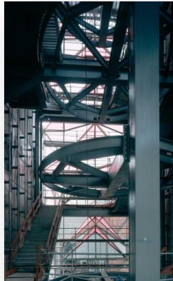
Photo169:La structure métallique des plateformes d'exposition Source : www.archdaily.com
