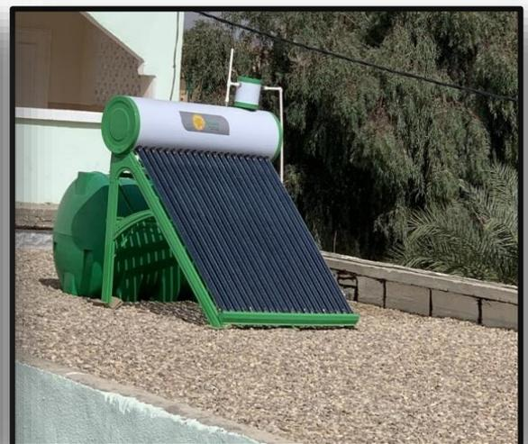
Figure 67 : photo réelle thermosiphon. Source pris par l'auteur
