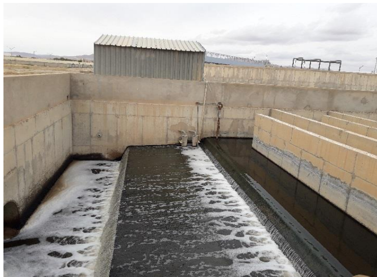
Figure I.10: Evacuation des eaux épurées de la STEP de Boussaâda.
