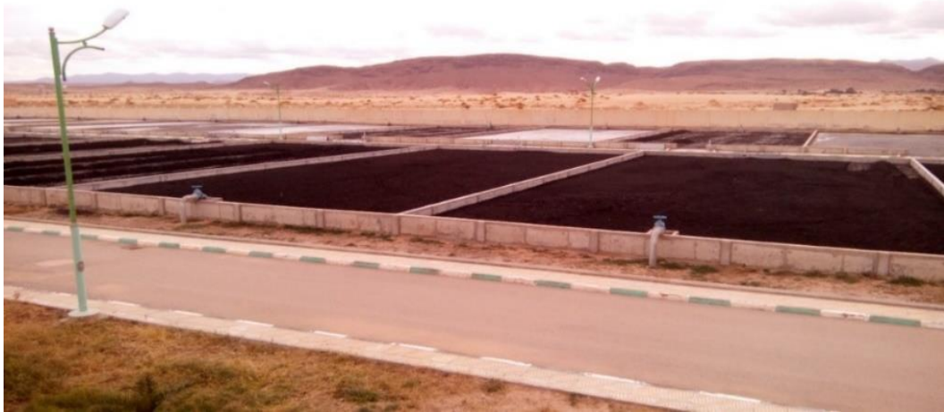
Figure I.13: Les lits des séchages de la STEP de Boussaâda.
