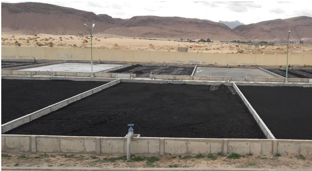
Figure II. 2: Les lits des séchages de la STEP de Boussaâda.
