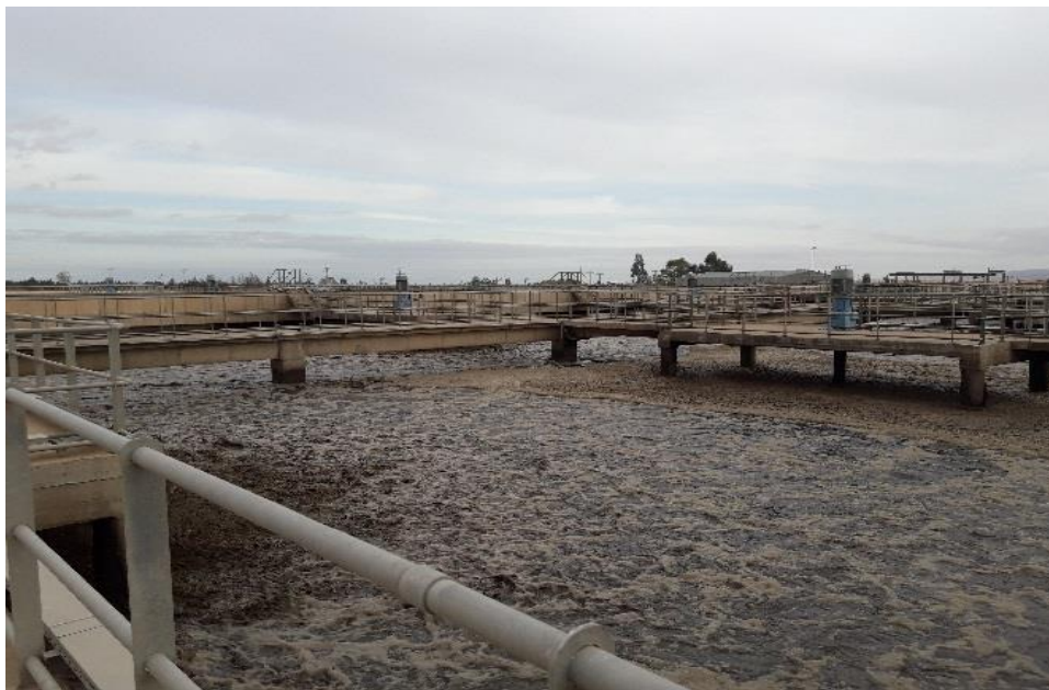
Figure I.7: Bassin biologique de la STEP de Boussaâda.
