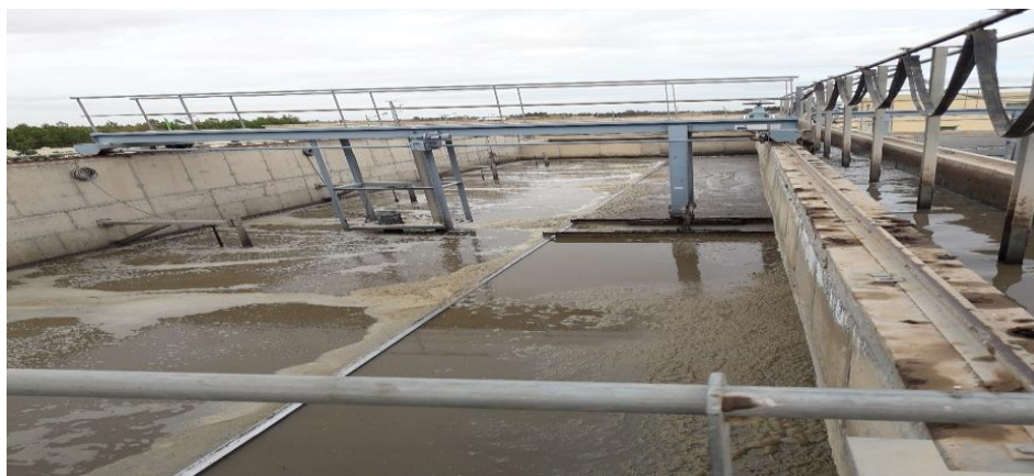
Figure I.6: Dessableur/Déshuileur de la STEP de Boussaâda.
