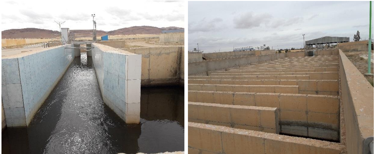
Figure I.9: Canal de chloration (chicanes) de la STEP de Boussaâda.
