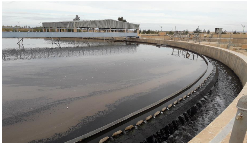
Figure I.8: Décanteur secondaire de la STEP de Boussaâda.
