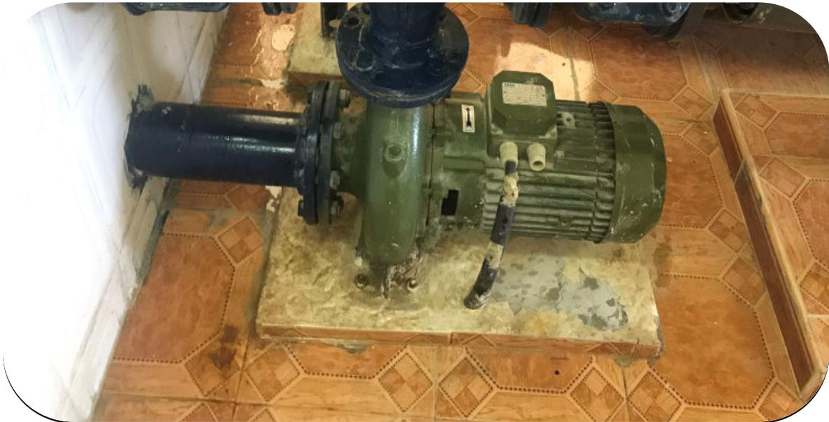
**Figure (1.5):** Photographie de pompe centrifuge axiale.
