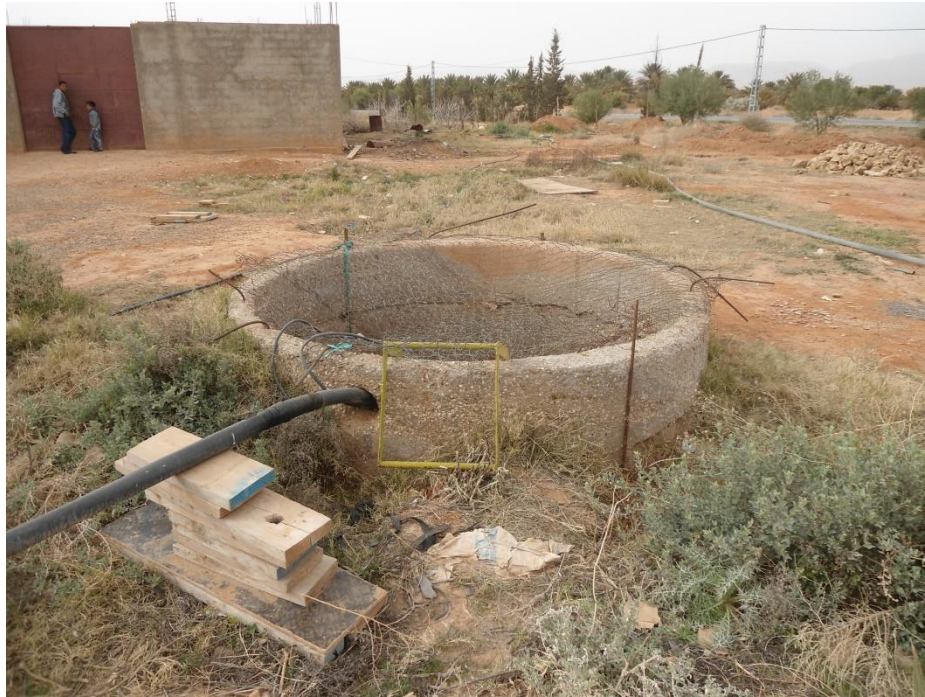
Figure II.1 : Puits maçonné de 2m de diamètre.
