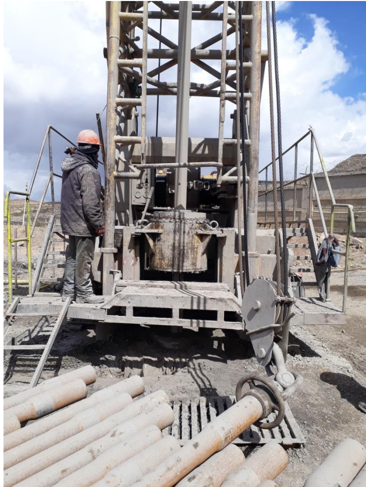
Figure II.2 : Un forage en cours de réalisation [2].
