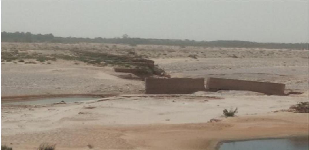
Photo 1 :L'ancien seuil en gabions le long transversal de Oued Djedi (lahlali 2019)
