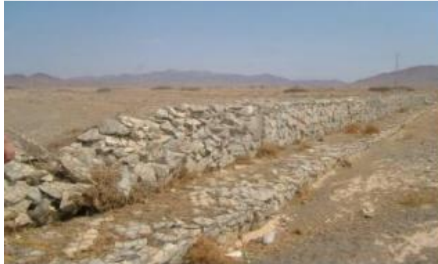
Photo 06 : Seuil en gabion( Moussajjal.N , Boudahk.N ,2014)
