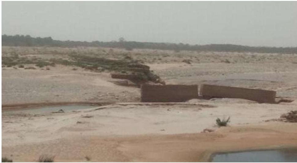
Photo 04 :L'ancien seuil en gabions le long transversal de Oued Djedi (LAHLALI .A ,2019)
