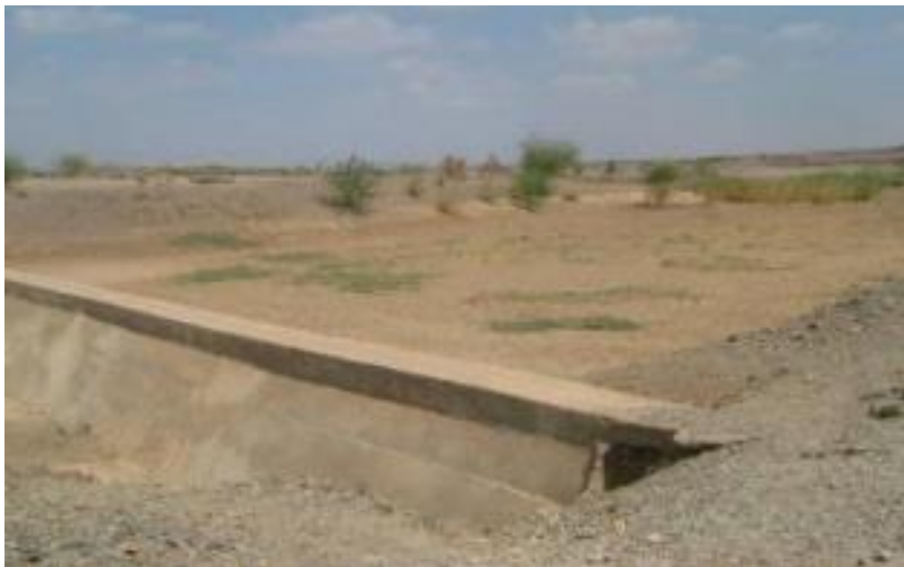
Photo 05 :Seuil en béton ( Moussajjal.N , Boudahk.N ,2014)
