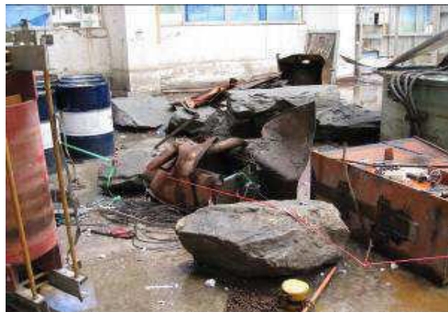
Figure 2.12: Intérieur de l'usine de Shapai abîmée par des chutes de blocs
