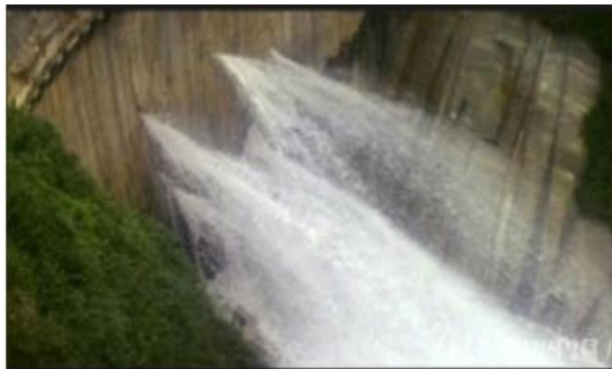
Figure 1.12 : problèmes de fuite d'eau dans les barrages (Toumi et al,2003)
