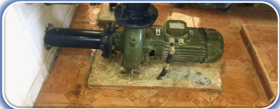
Figure (1.7): Photographie de pompe centrifuge axiale.
