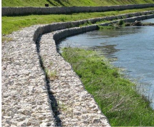
Figure II.15: Exemples de réalisation d'un mur en gabion
