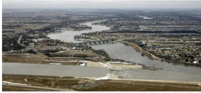
Figure II.7: Canal de dérivation
