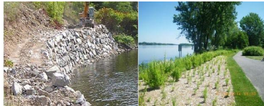
Figure II.14 : aménagement avec maçonnerie a gauche et a droite en enrochement liaisonnée
