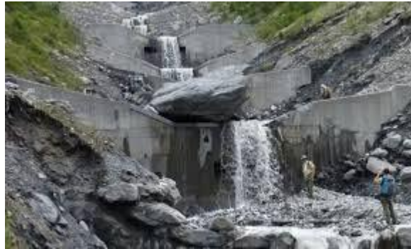
Figure II.4 : Fonctions des barrages de correction torrentielle
