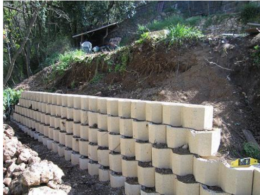
Figure II.12: Protection avec des blocs de béton creux
