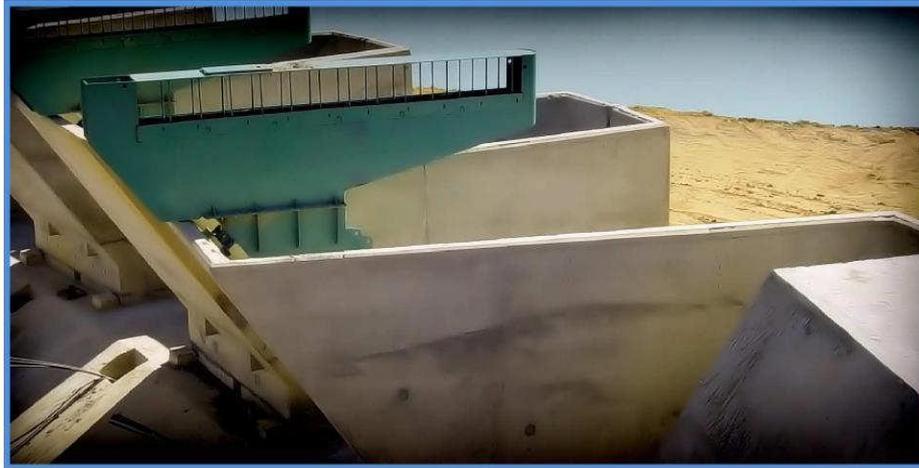
**Figure I.9** puits d'alimentation solidaire de la hausse (en acier).
