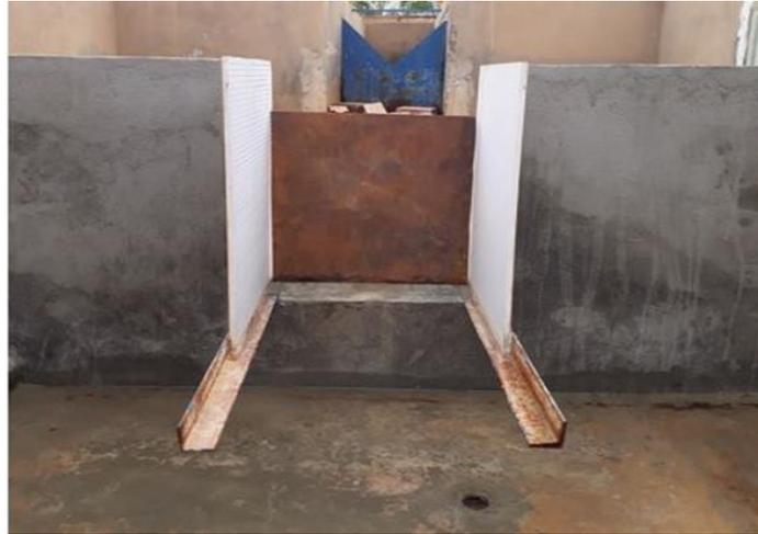
**Figure III.10** Vue aval du déversoir portant une tôle pliante
