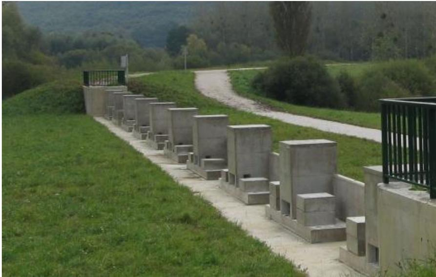
**Figure I.34** Déversoir digue fusible (France)
