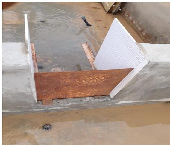
**Figure III.11** Vue amont du déversoir portant une tôle pliante
