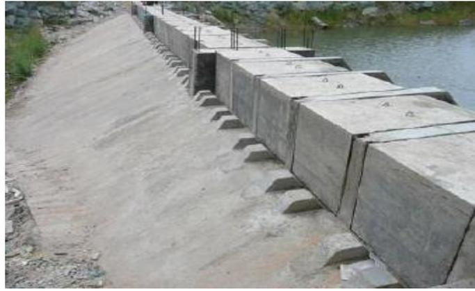
**Figure I.22** blocs fusibles sur un seuil avec des murs séparateurs.
