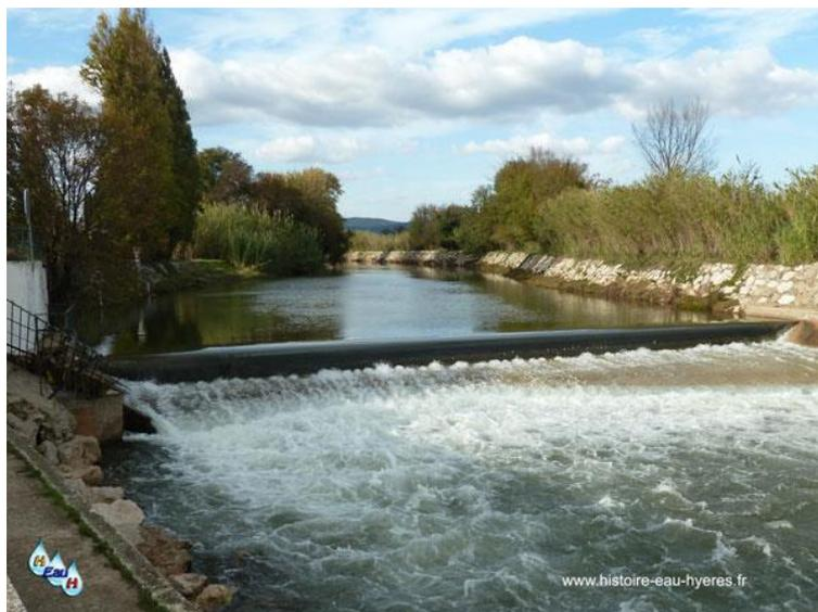
**Figure I.36** Barrage anti-sel de 1969 avec son boudin gonflable
