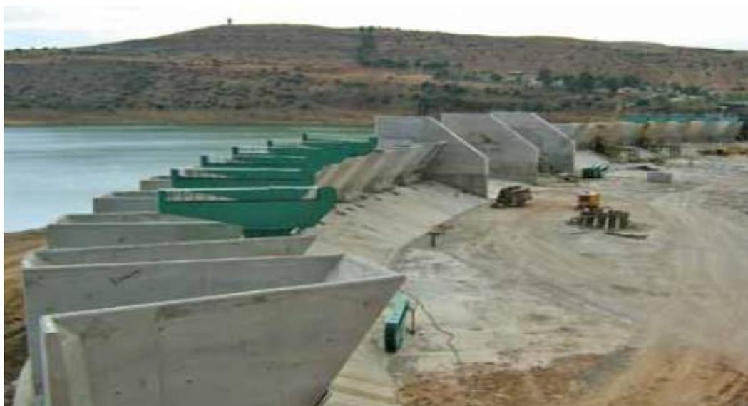
**Figure I.2** Les hausses fusibles à seuil labyrinthe.
