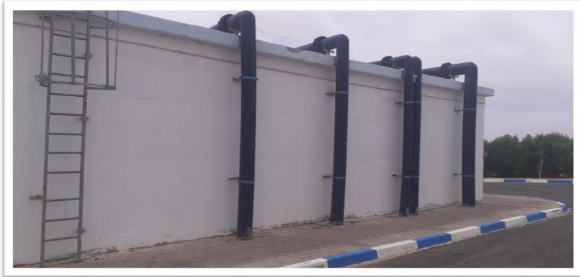
Figure 14 : Bassin d'eau brute
