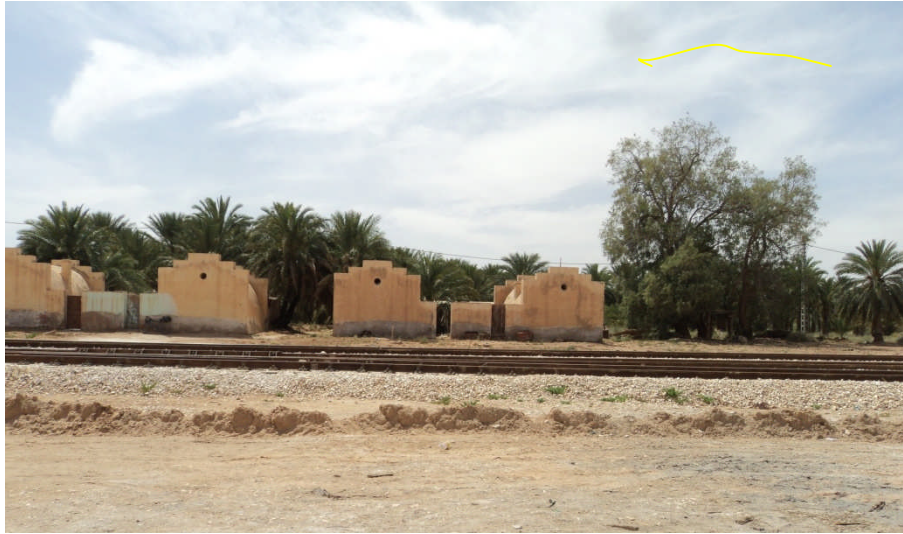
Figure 16 : Zone urbaine touchée par les inondations
