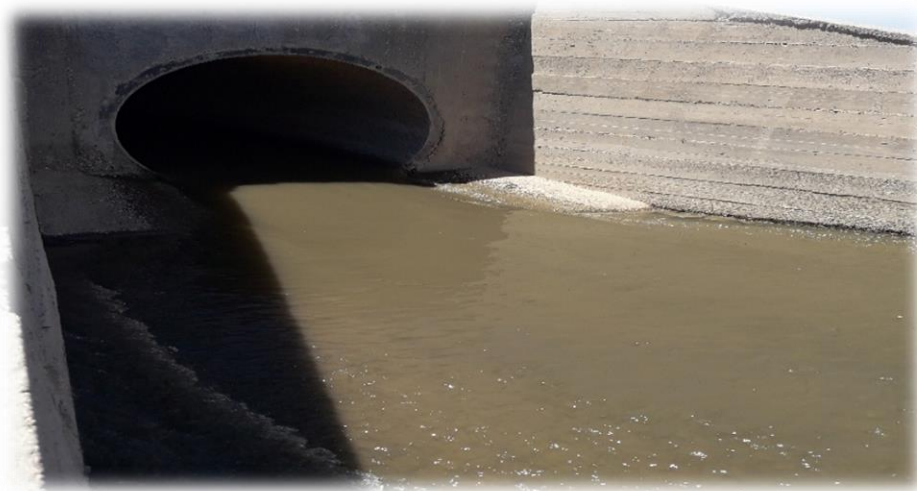
الشكل (07) : مصب مياه الصرف الصحي المنزلي (منطقة لبشاش)
