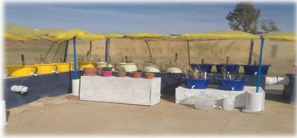
الشكل (08): محطة المعالجة.
