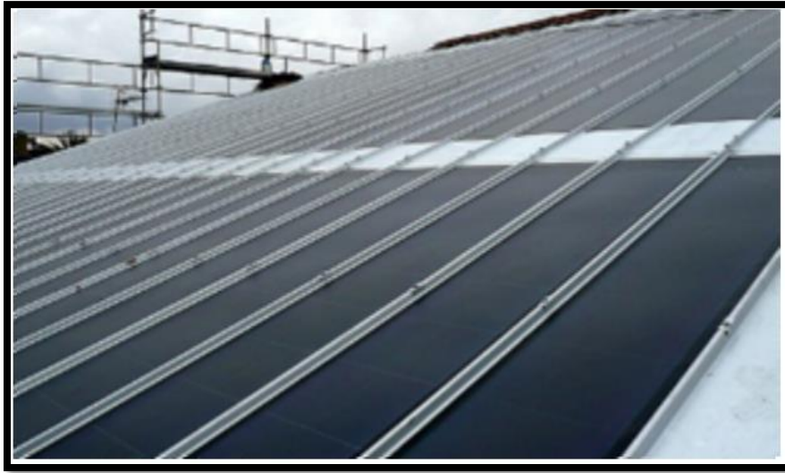
Figure. I. 3 : Photo d'un groupe de capteurs solaires non vitrés. [3]
