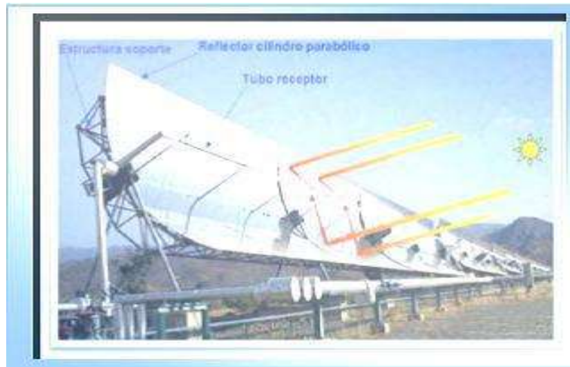
Figure (II-23): Ferme de capteur cylindro-paraboliques [22].
