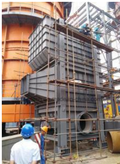
Figure I.11 Échangeur à bloc
