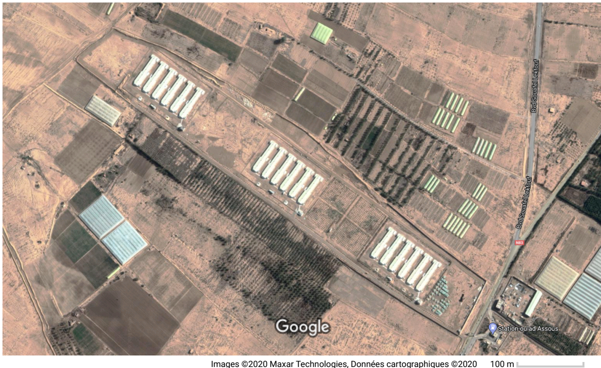
Figure III.1 : photo de site groupe Salem Sidi Okba donnée par Google Maps [29]
