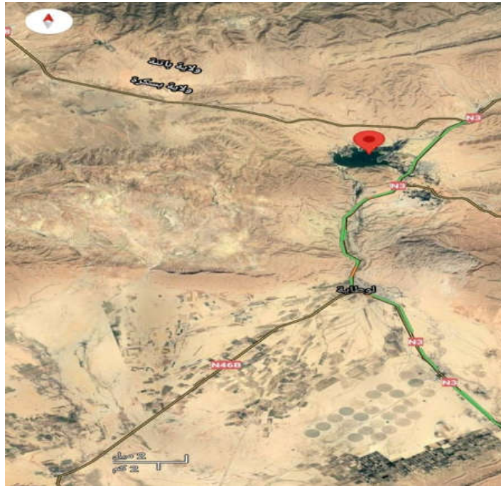
Figure 2 :Vue satellitaire de site d'étude du Barrage Fontaine des gazelles (Site web1).
