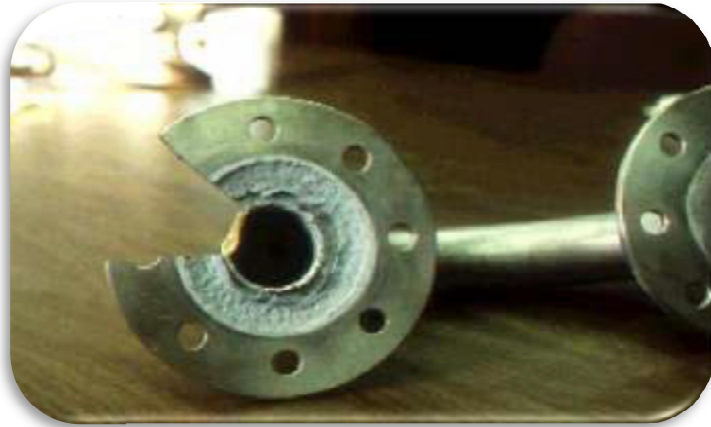
الشكل (1-6): صورة للتآكل الشقي
