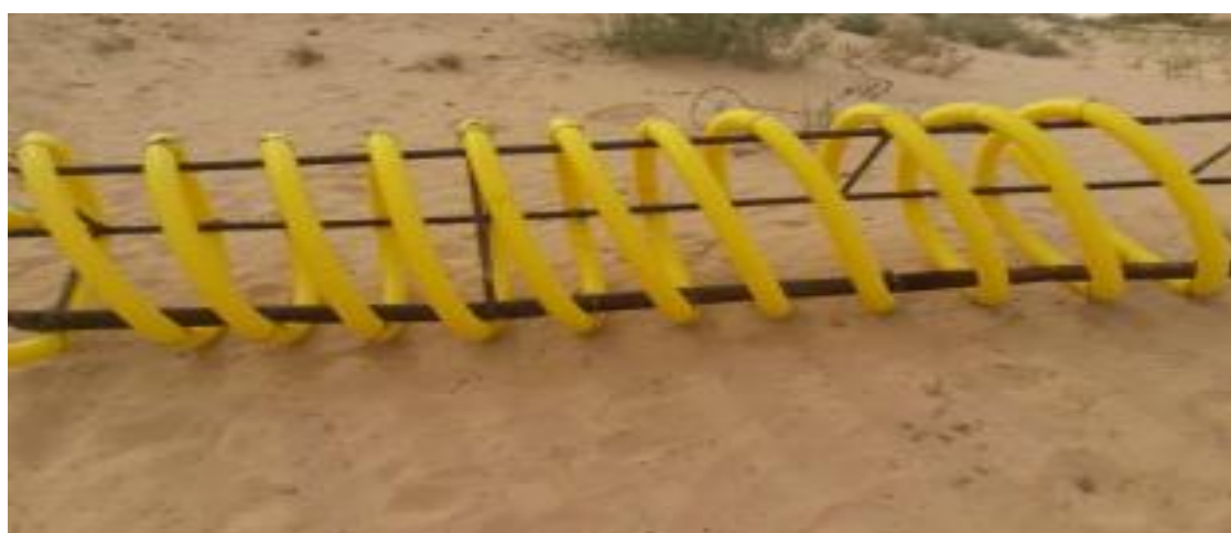
Figure 2.5 : Mise en place de l'échangeur HWAHE (Hadjadj 2021).
