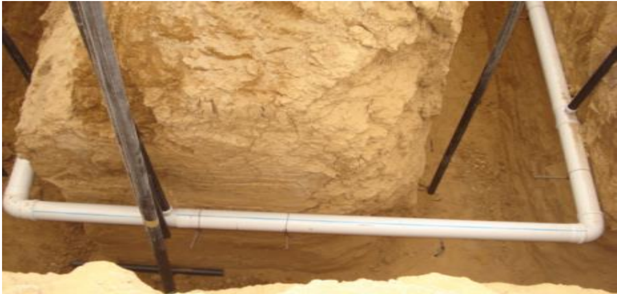
Figure 2.2 : Image de l'échangeur de chaleur horizontal à différentes profondeurs. (Hatraf 2014).
