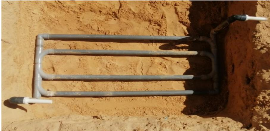
Photo (III-1): Échangeur à quatre tubes.
