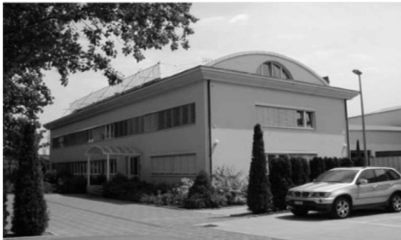
FIGURE 1.4 – Bâtiment Perret à Satigny [6].
