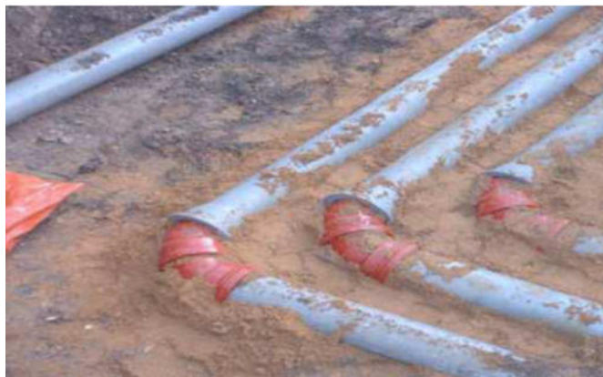
Figure .II.12. Echangeur géothermique [26].
