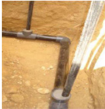
Figure I.2. Emplacement des capteurs de température dans le tube enterré [23].
