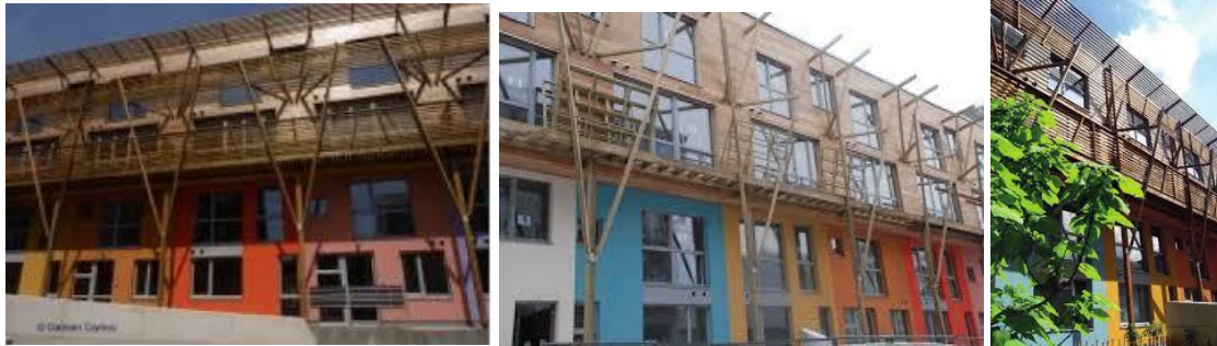
Fig.II.36/37/38. Vue sur Logement collectif – nouvelle construction
