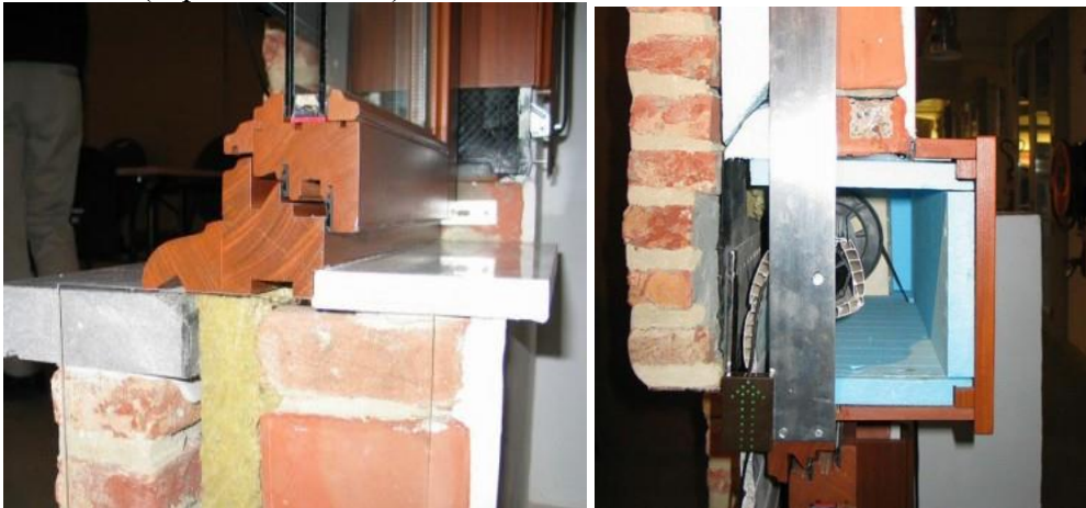
Fig.II.27/28 : détail de fixation d'une double fenêtre
