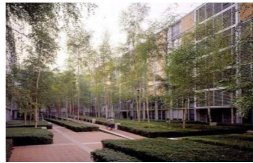
Fig.II.42. Vue du jardin intérieur
