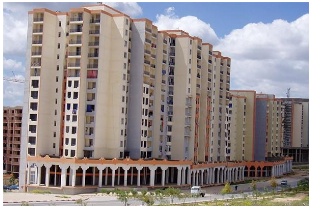
Fig.I.03.330000 logements collectifs à Alger
