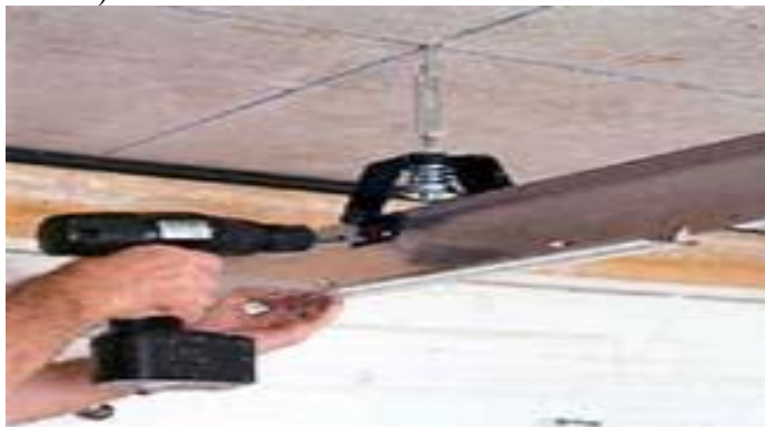
Fig.II.35. Détail de fixation du faux plafond
