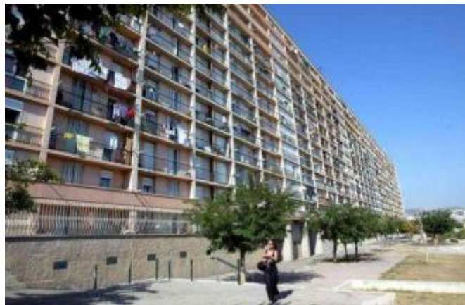
Fig.I.08. Un bâtiment (HLM)
