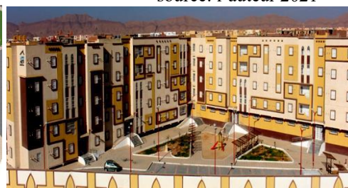
Fig.II.50. Vue sur la cour du logement
