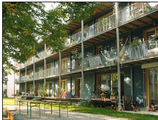
Fig.II.22 : Façade sud des maisons passives
