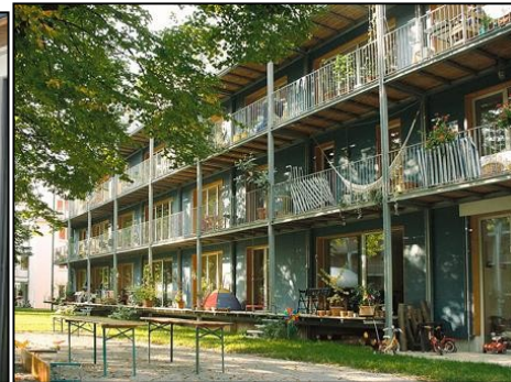
Fig.II.07 : Absence de séparation Vauban.
