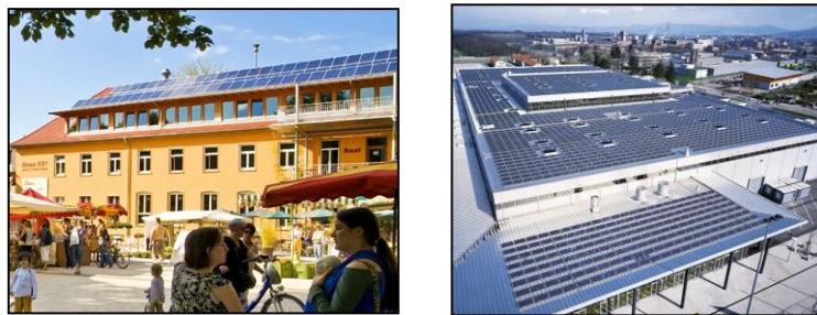
Fig.II.26 : Les photovoltaïques dans les équipements Source : zolucider.blogspot.com
