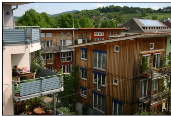
Fig.II.02 : Vue sur éco-quartier Vauban.
