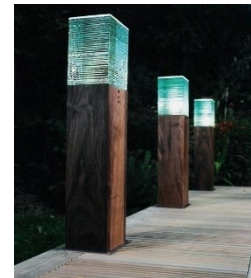
الصورة 42 : أعمدة إنارة خاصة بممر المشاة
