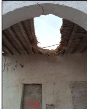
صورة رقم 97 سقوط اجزاء من السقف
