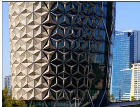
Figure 23 : Le système dynamique d'ombrage a Al Bahar Tours. (Source : <https://laviebohemettravel.wordpress.com>)
