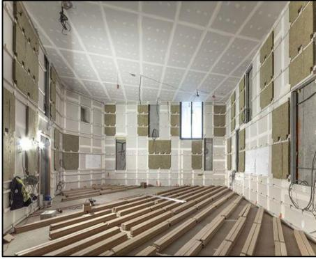
Dans les autre espace dès Les plaques fermacell de 15 et 18 mm d'épaisseurs etposées sur ossatures métallique
