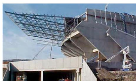
Figure A.13: Zénith de Saint Etienne structure      Figure A.12: L'ossature de l'auvent est constituée En poutre en console en treillis (archdaily.com par 10 consoles treillis( archiexpo.com)
