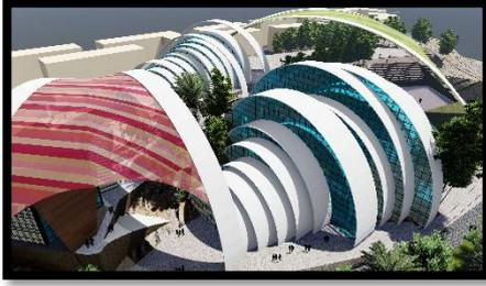
La Peau extérieure en acier tenté par une peinture isolante blanche qui reflète les rayons du soleil (SRI > 107) ce qui permet de réduire de 10 à 40°C la température sous le support.
