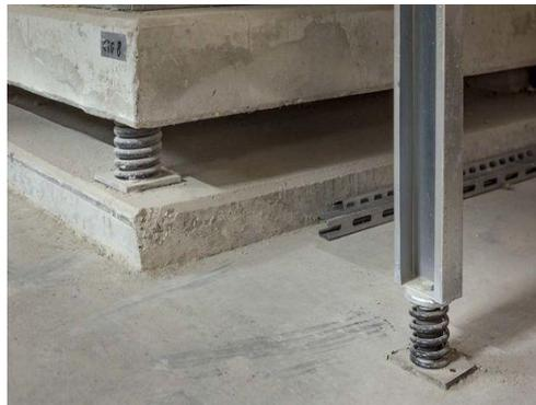
**Figure 103 :** Système d Isolées du sol par desboîtes à ressorts(le
