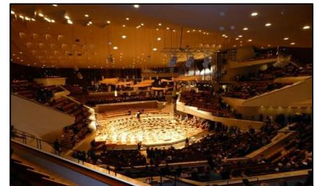
En fonction de la jauge, la forme de base peut induire des distances importantes entre la scène centrale et les murs, d'où un manque d'énergie précoce dans les premières places autour de la scène.L'ajout de pans de murs partiels (sur hauteurs partielles), permet d'ajouter des réflexions précoces dans cette partie de la salle.
