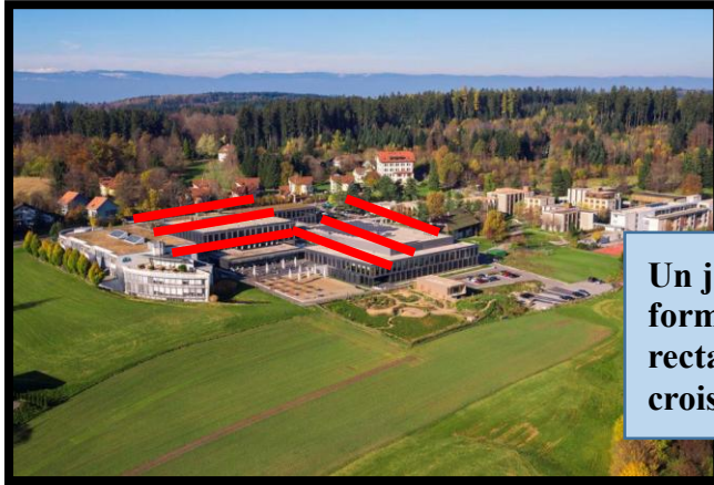
Figure 89: vue lointaine de l'école Lausanne
