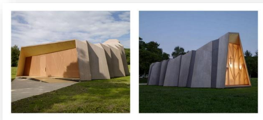
Figure40 : vue extérieure de la chapelle
