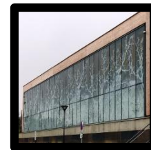
figure 23 : La façade VEC
