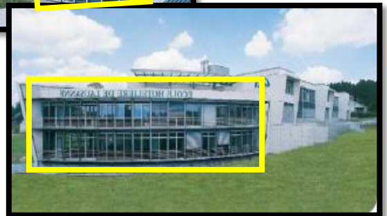
Figure 94 : traitement façade sud
