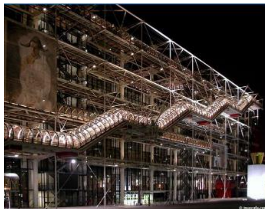
Figure 38: le centre pempidou source : www.centrepempidou.fr
