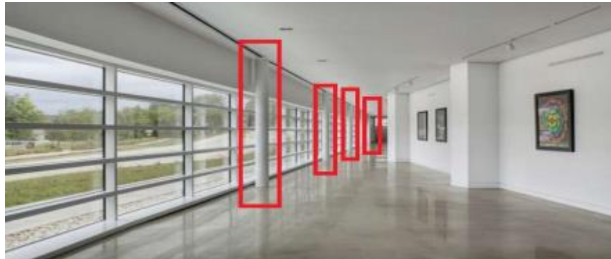
Figure 89: des poteaux métallique source : archidaily.com
