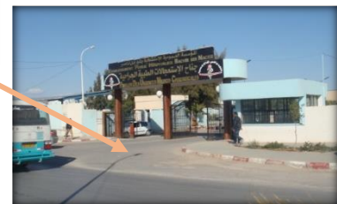
Figure 109: hopital bachir benase rsource : auteur 2019
