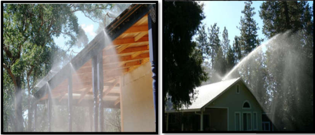
صورة 3- اعتماد المياه على الاسقف للتقليل من الاكتساب الحراري
