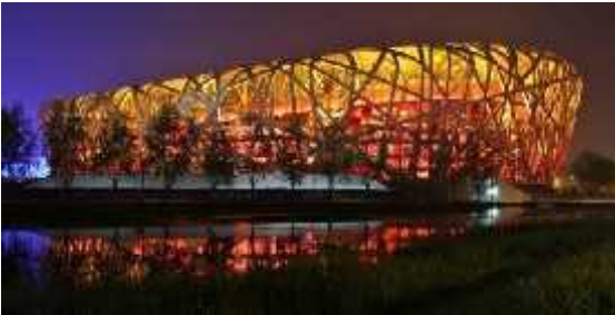
23: الغلاف الخارجي الخرساني كهيكل مشروع www.archdaily.com :
